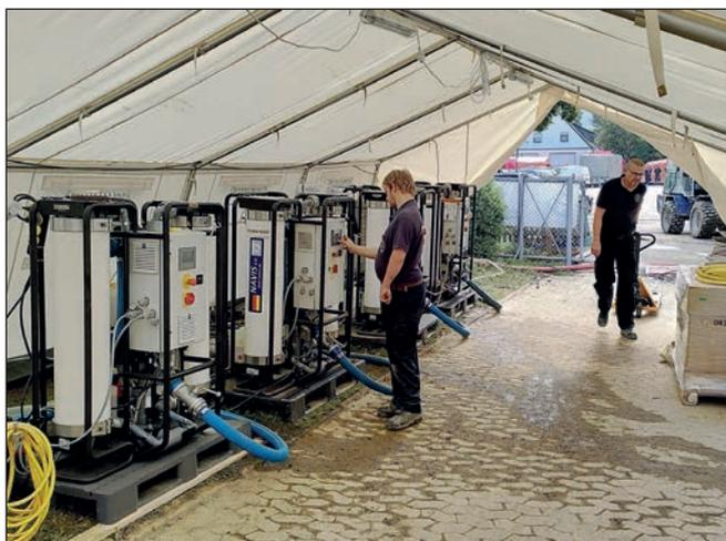
**Die Wasseraufbereitungsanlagen von Kärcher Futuretech im Fluthilfe-Einsatz in Ahrweiler.**
