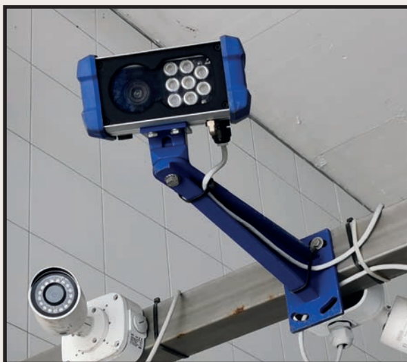
Mit dieser Kamera wird das Kennzeichen gelesen und freigegeben.
