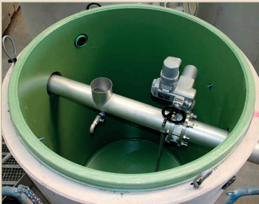
Der Blick ins Sicherheitsauffangbecken zeigt Durchverrohrung, Absperrklappe mit Schwenkantrieb und Überlaufstutzen.
